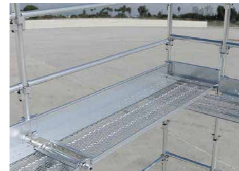
施工イメージ
